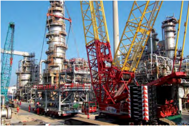
หน่วยผลิตไฟฟ้าที่ประกอบไว้ล่วงหน้าได้ถูกขนส่งมาถึงบริเวณก่อสร้างของโครงการปรับปรุงคุณภาพน้ำมัน
