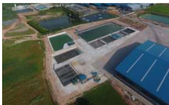
ระบบบำบัดน้ำเสีย เฟส 2 ก่อสร้างเมื่อปี 2563
