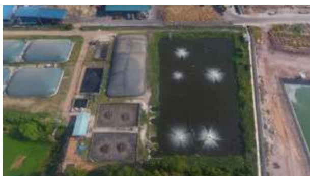
ระบบบำบัดน้ำเสีย เฟส 1 ก่อสร้างเมื่อปี 2557
