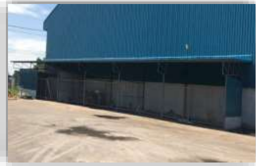
อาคารพักขยะ
