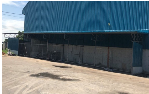
อาคารพักขยะ
