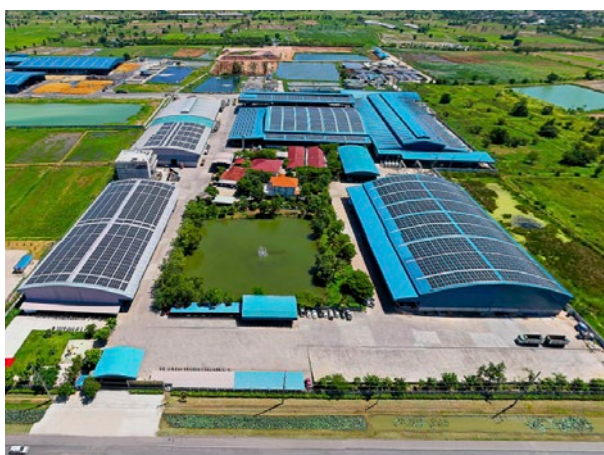
โครงการผลิตไฟฟ้าจากพลังงานแสงอาทิตย์ที่ติดตั้งบนหลังคา
